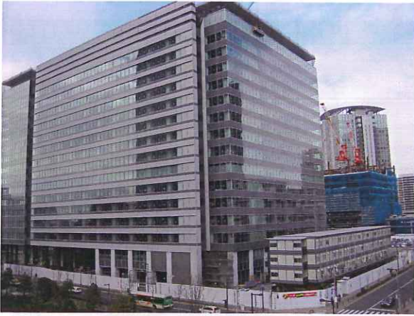
現場の現状風景です、野田工業(株)の工区は B 1 F と B 2 F で現在 95% の出来高です。
