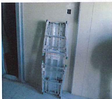
簡易足場の立て掛け
